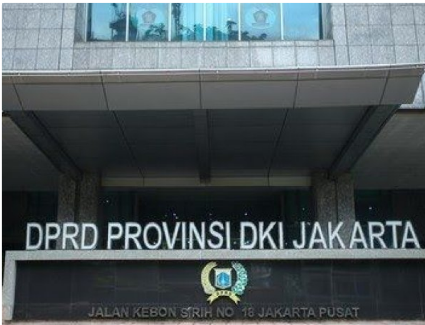
Gedung DPRD DKI Jakarta Jl. Kebon Sirih, Jakarta Pusat
